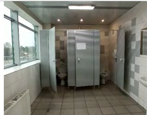
Фото 85. Внутренние помещения 4 этажа.
