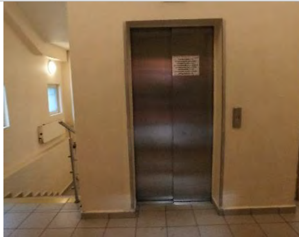
Фото 61. Внутренние помещения 3 этажа.
