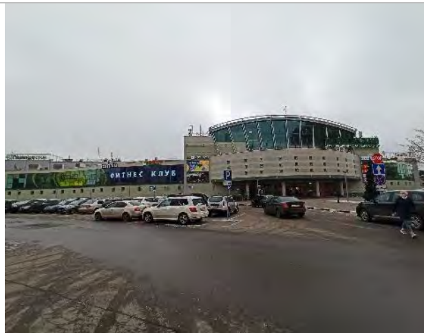
Фото 164. Фасад и прилегающая территория
