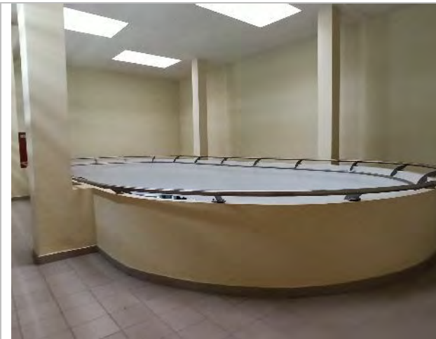
Фото 79. Внутренние помещения 4 этажа.
