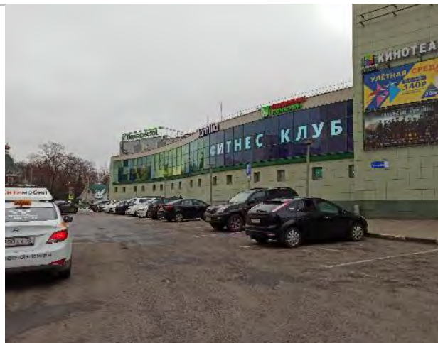
Фото 166. Фасад и прилегающая территория
