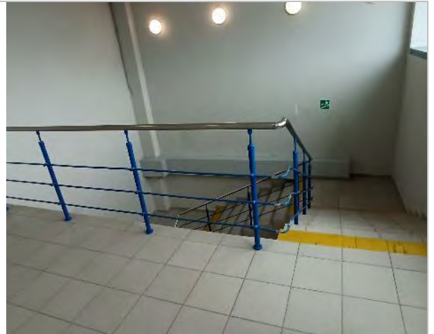
Фото 74. Внутренние помещения 4 этажа.
