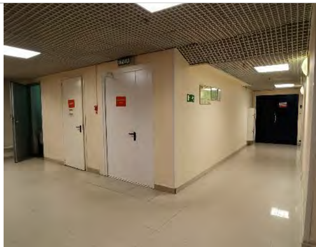
Фото 132. Внутренние помещения цокольного этажа.
