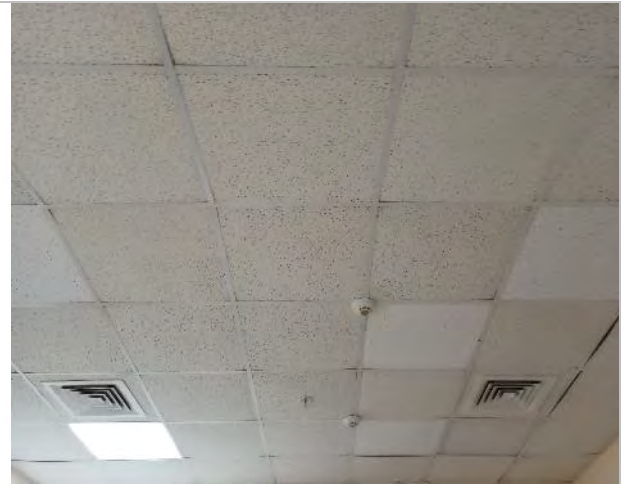
Фото 98. Внутренние помещения 4 этажа.
