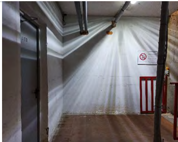
Фото 113. Внутренние помещения цокольного этажа.
