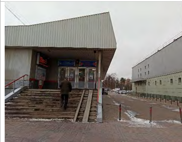
Фото 153. Фасад и прилегающая территория
