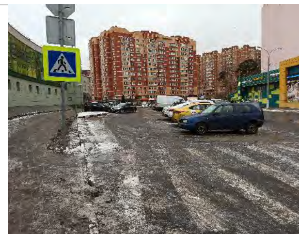
Фото 161. Фасад и прилегающая территория
