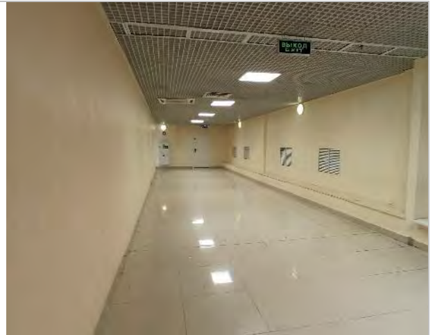
Фото 134. Внутренние помещения цокольного этажа.
