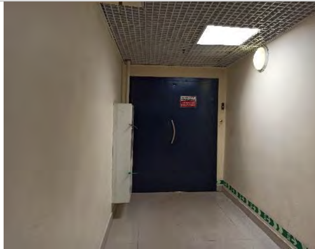
Фото 140. Внутренние помещения цокольного этажа.
