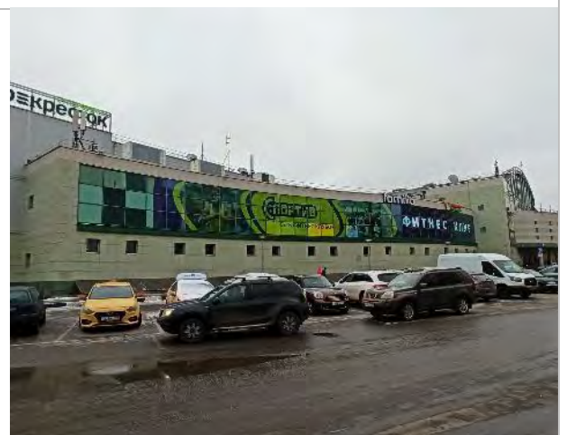
Фото 162. Фасад и прилегающая территория
