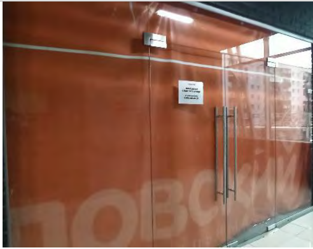
Фото 55. Внутренние помещения 3 этажа.
