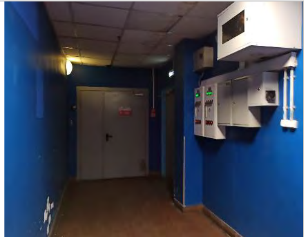
Фото 146. Внутренние помещения цокольного этажа.
