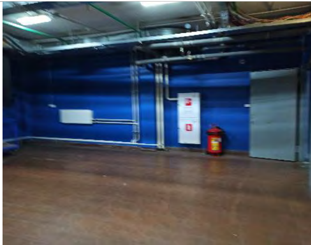
Фото 141. Внутренние помещения цокольного этажа.
