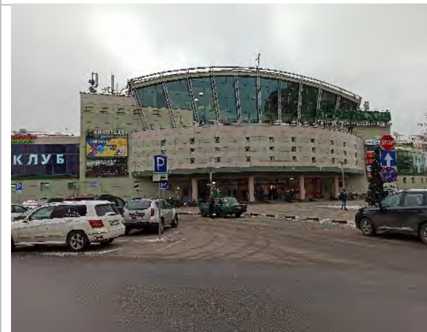
Фото 165. Фасад и прилегающая территория
