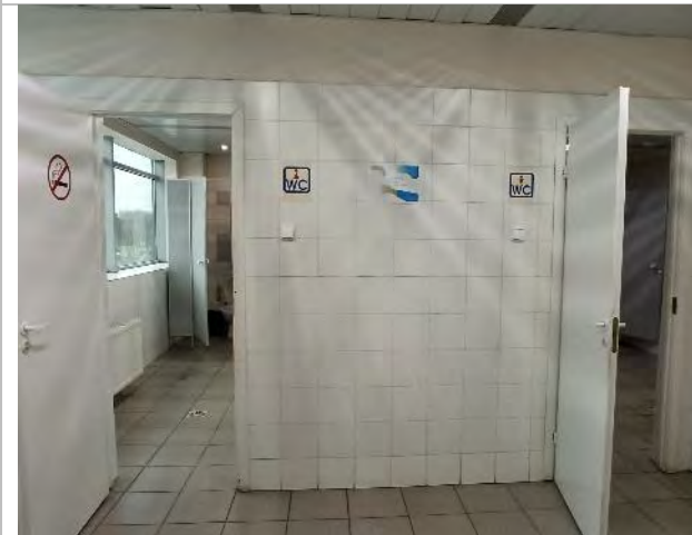
Фото 83. Внутренние помещения 4 этажа.
