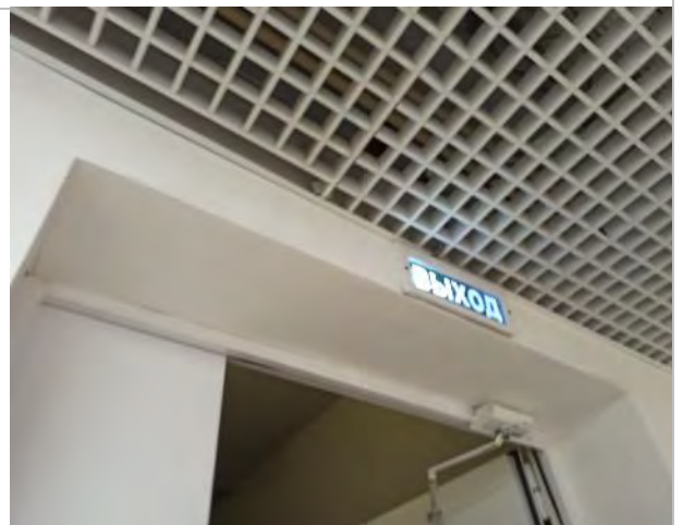
Фото 138. Внутренние помещения цокольного этажа.
