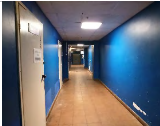
Фото 144. Внутренние помещения цокольного этажа.
