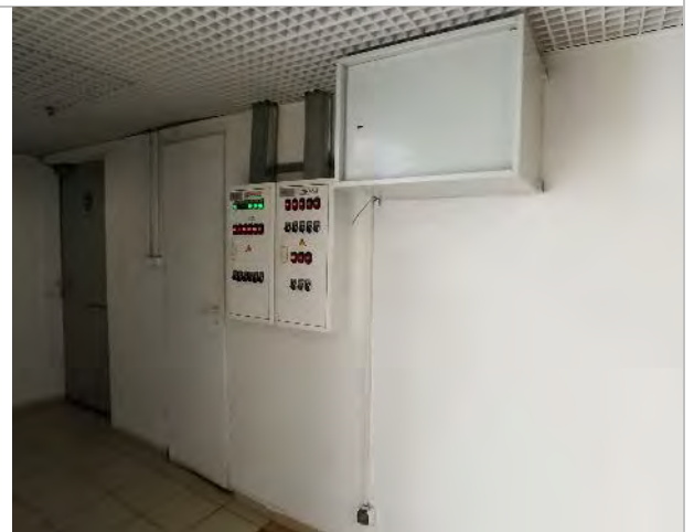
Фото 126. Внутренние помещения цокольного этажа.
