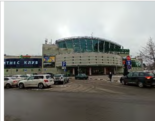
Фото 163. Фасад и прилегающая территория
