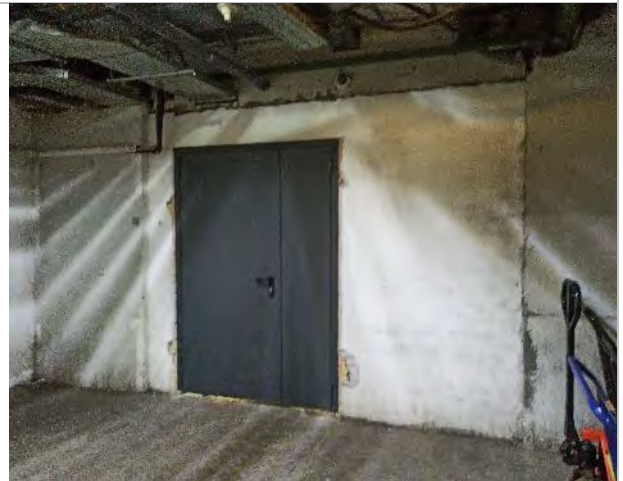
Фото 148. Внутренние помещения цокольного этажа.
