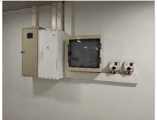
Фото 112. Внутренние помещения цокольного этажа.
