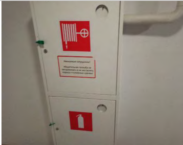
Фото 115. Внутренние помещения цокольного этажа.
