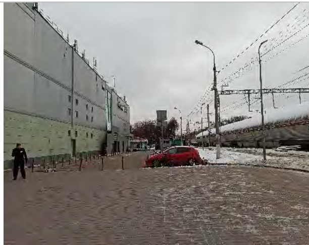
Фото 152. Фасад и прилегающая территория
