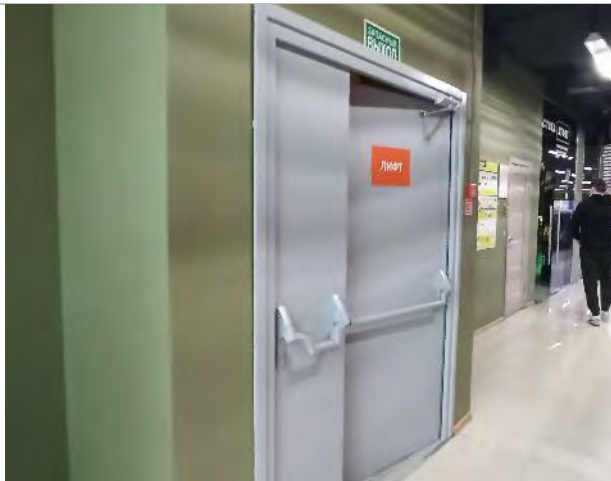
Фото 59. Внутренние помещения 3 этажа.
