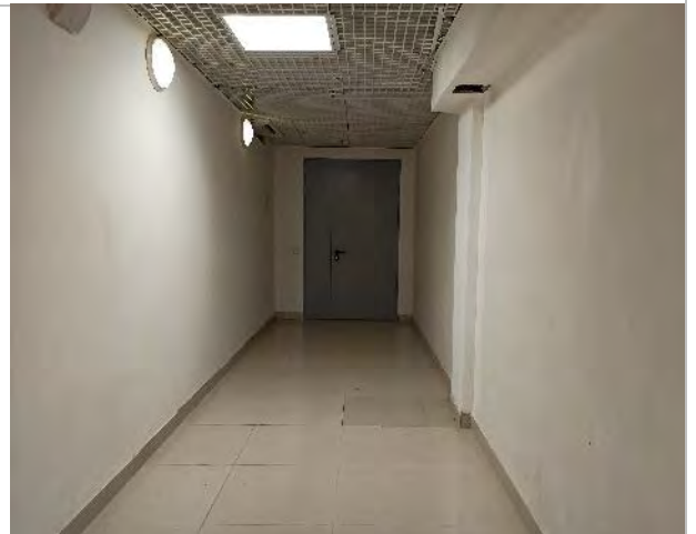
Фото 136. Внутренние помещения цокольного этажа.
